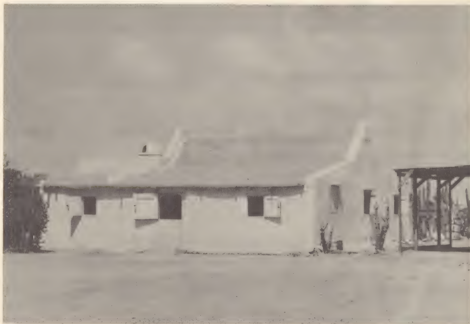
Kop- en zijgevel van een in 1912 gebouwd woonhuis met kalksteenmuren en torto-dak
